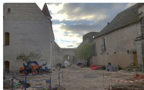
Restauration de la cour intérieure, février 2024.
