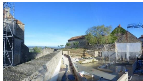
Construction du nouvel accueil.
